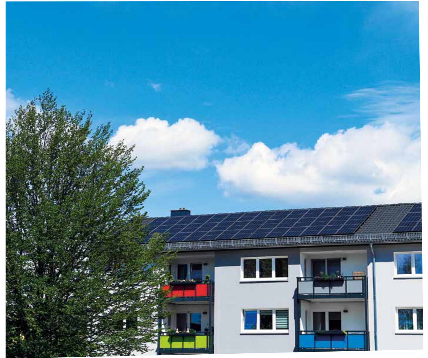
Photovoltaikanlagen auf den modernisierten Häusern am Spannbrink 69/71 und 73/75 erzeugen den ökologischen Mieterstrom.
